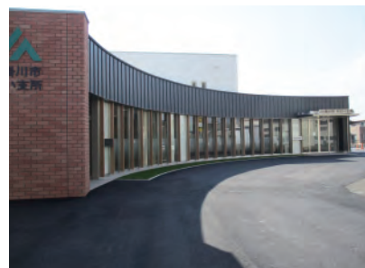
壁材として使用した事例
