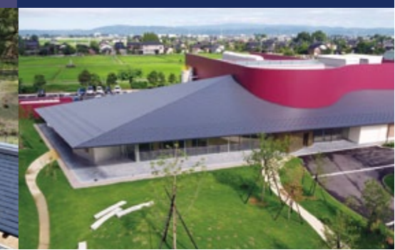
■株式会社能作 新社屋・工場(カラーGL鋼板) ●設計/アーキヴィジョン広谷スタジオ ●施工/塩谷建設株式会社
