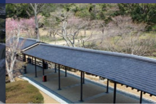
■新公会堂〜シルクロード交流館渡り廊下(硫化銅板) ●設計/(株)礎建築事務所 ●監理/(有)森馬都市創造設計 ●施工/(株)尾田組
